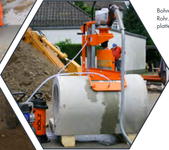
Bohren 90° am verlegten Rohr. Befestigung am Bodenrahmen mit Erdnägeln.
