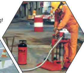
Gewicht des Bediener sorgt für festen Halt
